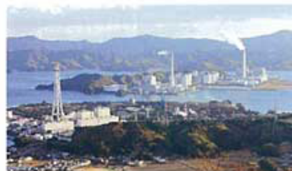
橘湾石炭火力発電所 阿南市橘町 風光明媚な橘湾。その小勝島に姿を現す西日本最大級の石炭火力発電所。【出力】280万kw(1号機:210万kw、2号機:70万kw)意外とファンタジックな夜景も見る価値あり。
