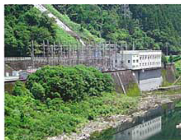
川口発電所 那賀町吉野 【発電方式】ダム式【最大出力】11,700kw
