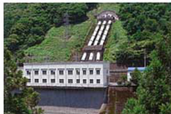
ひのたに 日野谷発電所 那賀町日浦 長安口ダムから音谷の導水管を通ってきた水を発電に利用。【発電方式】ダム水路式【最大出力】61,000kw
