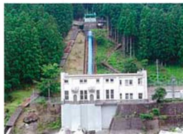
さかしゅう 坂州発電所 那賀町坂州 追立ダムから導水。レトロな雰囲気が漂う。【発電方式】流込水路式【最大出力】2,400kw
