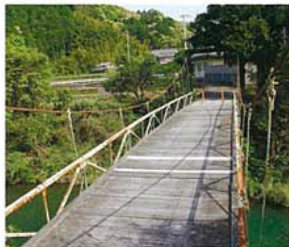
やすゆき 安行橋 阿南市新野町 木の橋げたのつり橋。
