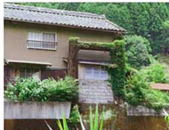
民家になった吊り橋 海陽町船津 主塔だけ残された吊り橋。そこにあつたはずの取り合い道路の上に民家が。
