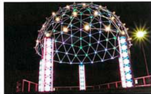
LEDの殿堂 キラキラ・ドーム 阿南市富岡町
